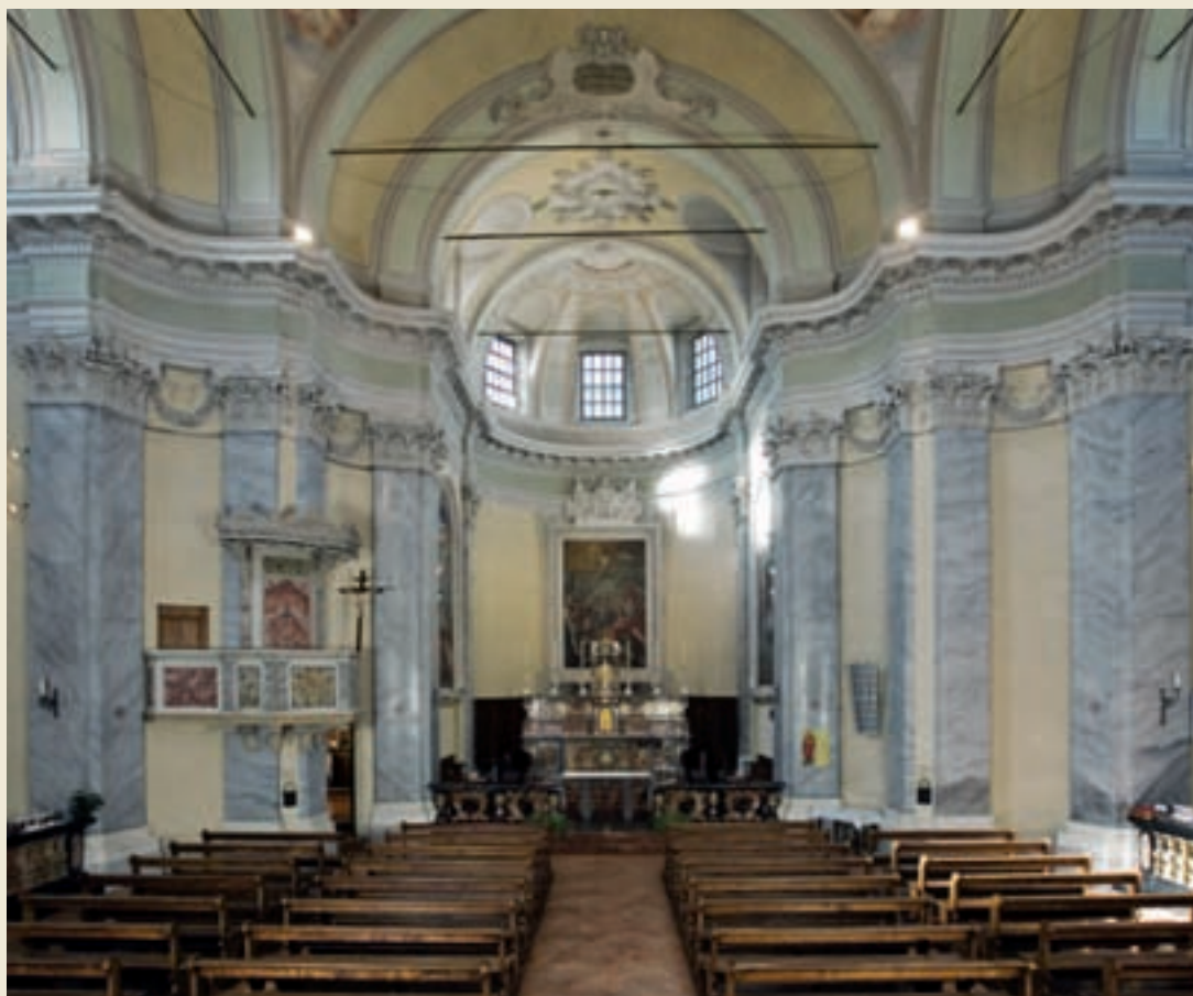
Interno della chiesa dopo i restauri 1979-1983
